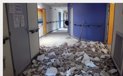
Début des travaux sur le FAM les Muscadelles
